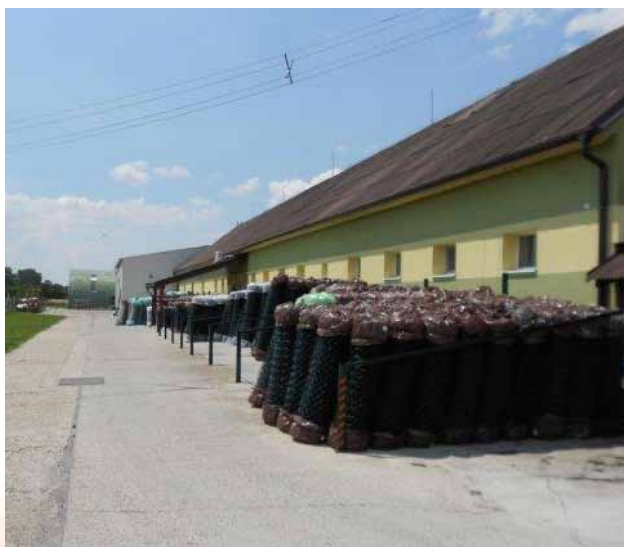
Rozľahlé skladové priestory pozdĺž hlavnej budovy prevádzky.
