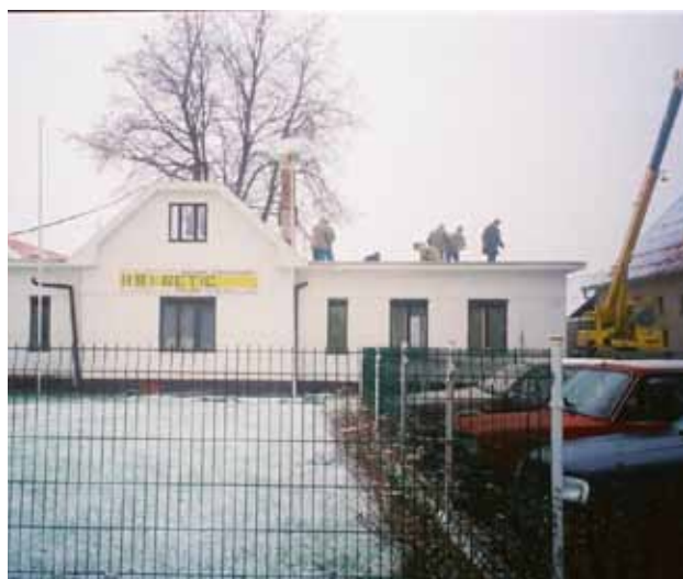
Rekonštrukcia starej administratívnej budovy.
