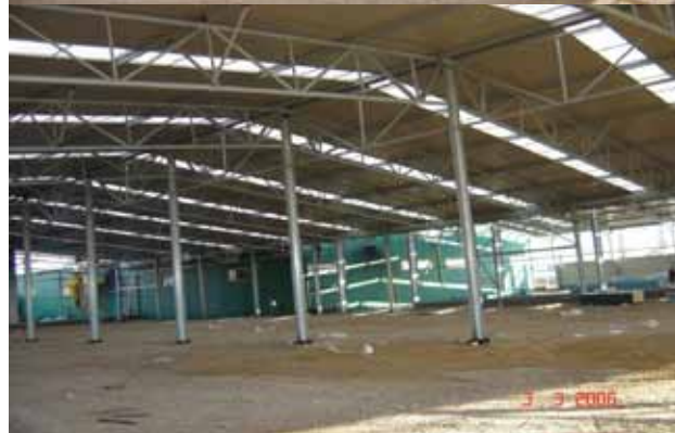
Priebeh výstavby nového výrobo-prevádzkového komplexu Reticu v Zbehoch.
