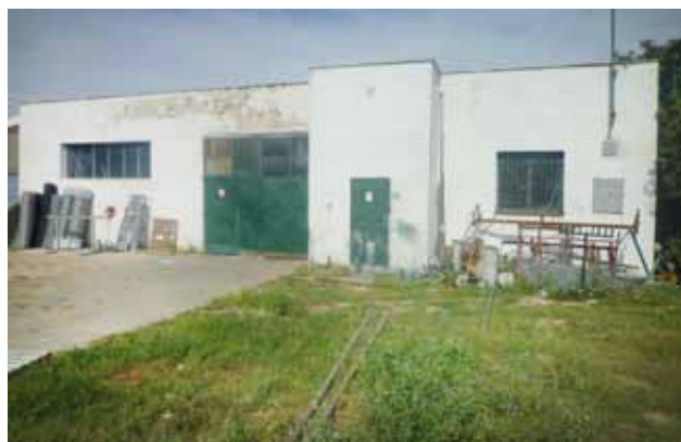
Hasičská zbrojnica, prvé historické sídlo Reticu.
